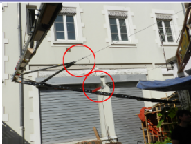
En fonctionnement normal, 2 câbles haubantent la structure. Un troisième, non tendu, est ajouté pour assurer toute défaillance des deux autres
