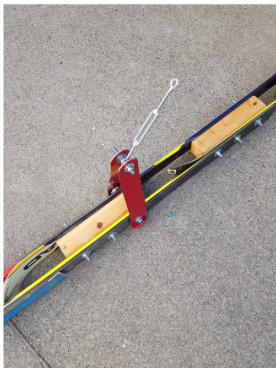
En fonctionnement normal, 2 câbles haubantent la structure. Un troisième, non tendu, est ajouté pour assurer toute défaillance des deux autres
